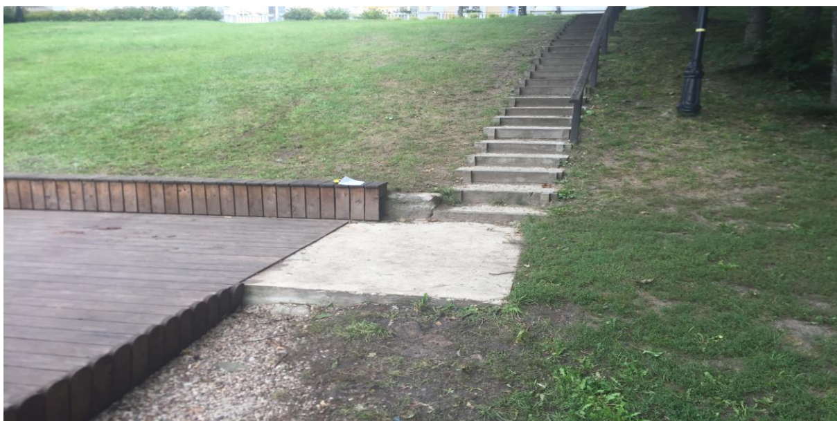
Zdjęcie nr 1: Płyta betonowa na gruncie do wyburzenia oraz murek oporowy.
